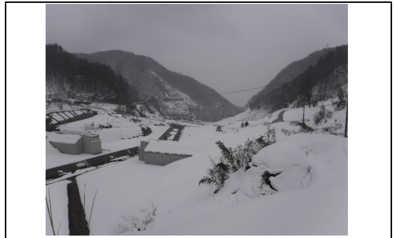
4 貯水池(上流からの全景)
