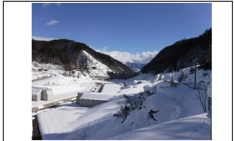
4 貯水池(上流からの全景)
