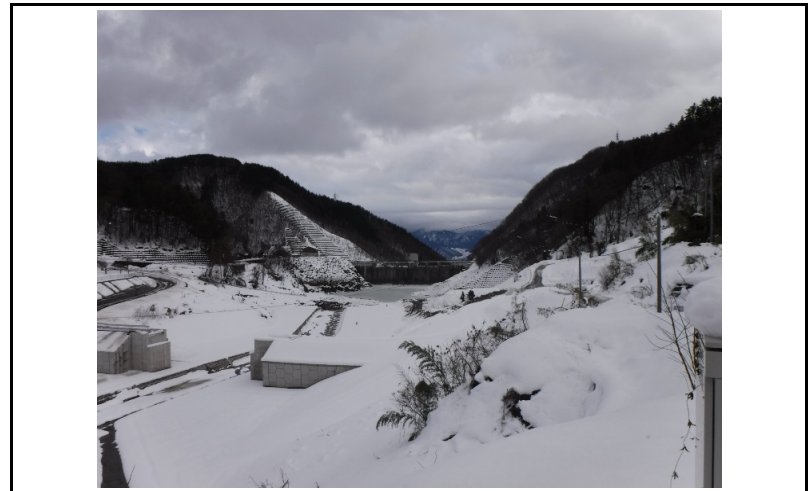
4 貯水池(上流からの全景)
