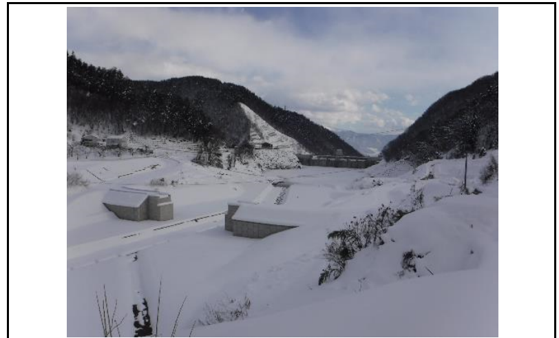
4 貯水池(上流からの全景)
