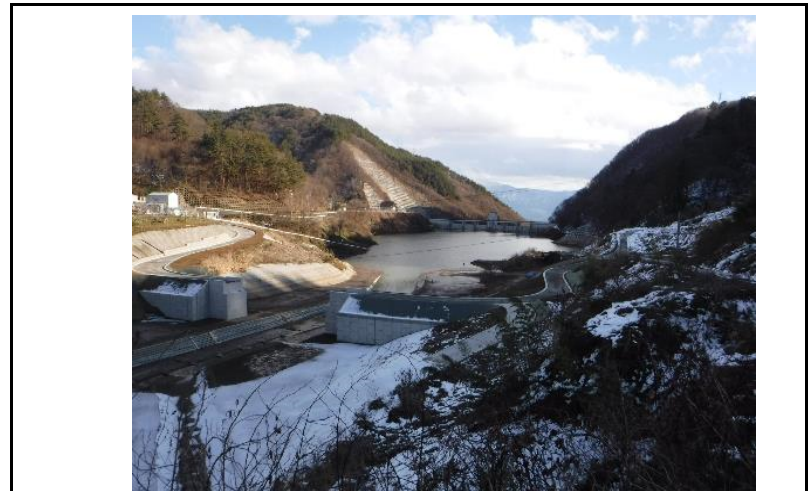
4 貯水池(上流からの全景)
