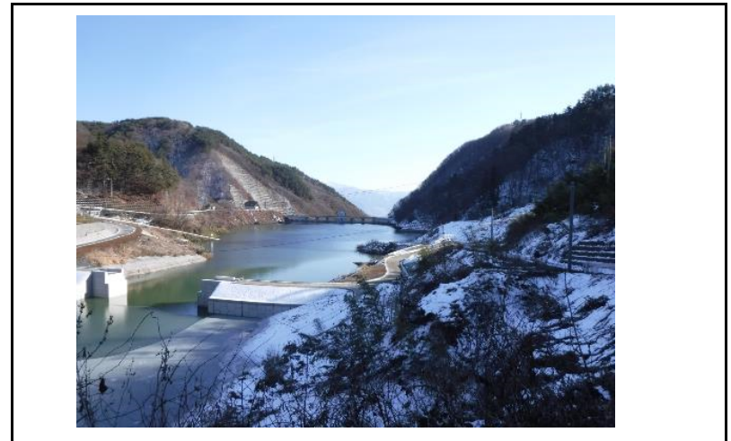
4 貯水池(上流からの全景)
