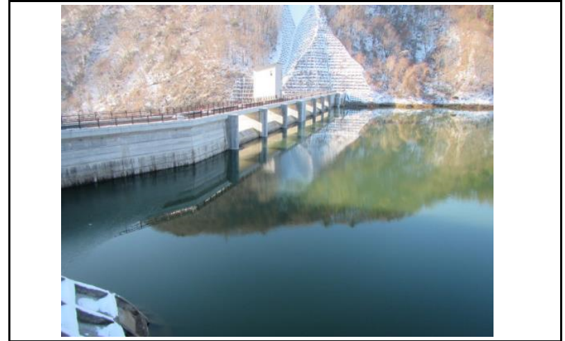
2 ダム上流面(左岸から)
