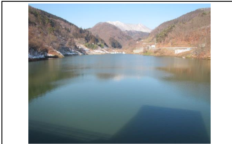
3 貯水池(ダムから上流)
