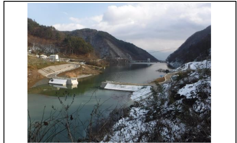
4 貯水池(上流からの全景)
