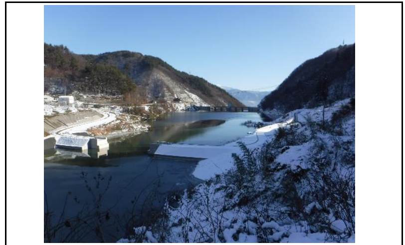
4 貯水池(上流からの全景)
