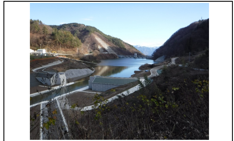
4 貯水池(上流からの全景)
