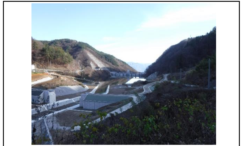
4 貯水池(上流からの全景)
