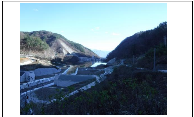
4 貯水池(上流からの全景)
