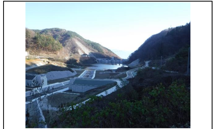
4 貯水池(上流からの全景)
