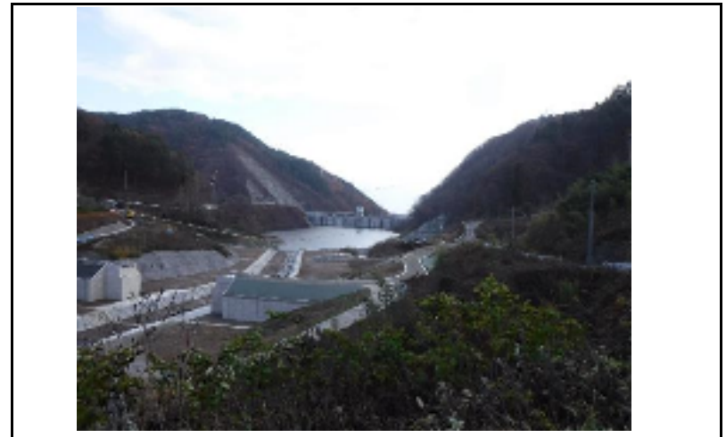
4 貯水池(上流からの全景)
