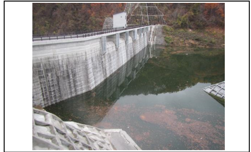
2 ダム上流面(左岸から)
