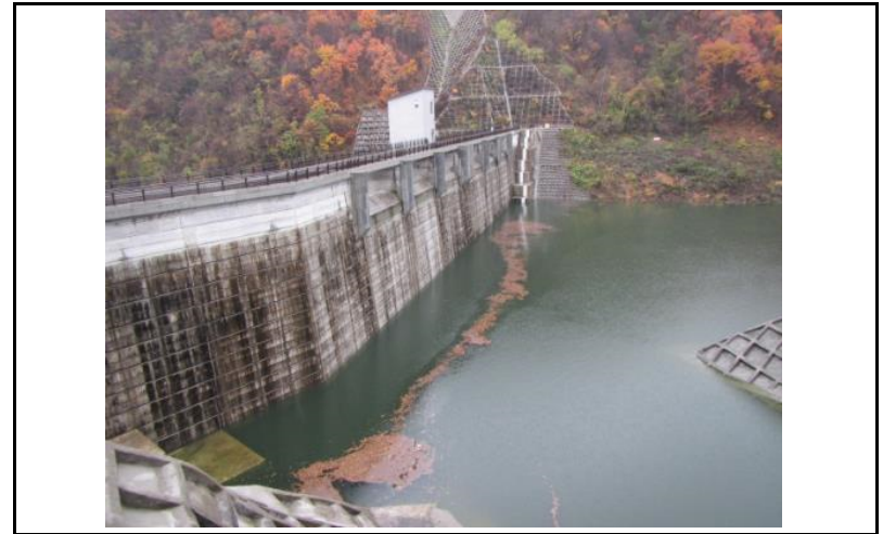
2 ダム上流面(左岸から)
