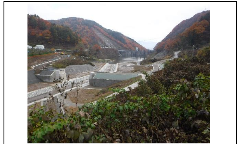
4 貯水池(上流からの全景)
