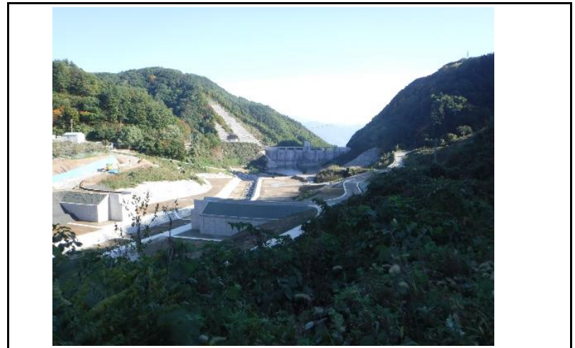
4 貯水池(上流からの全景)
