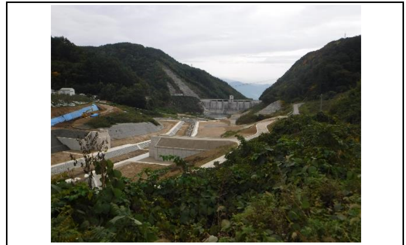
4 貯水池(上流からの全景)
